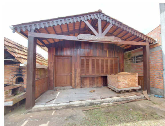
Foto da situação atual - frente
