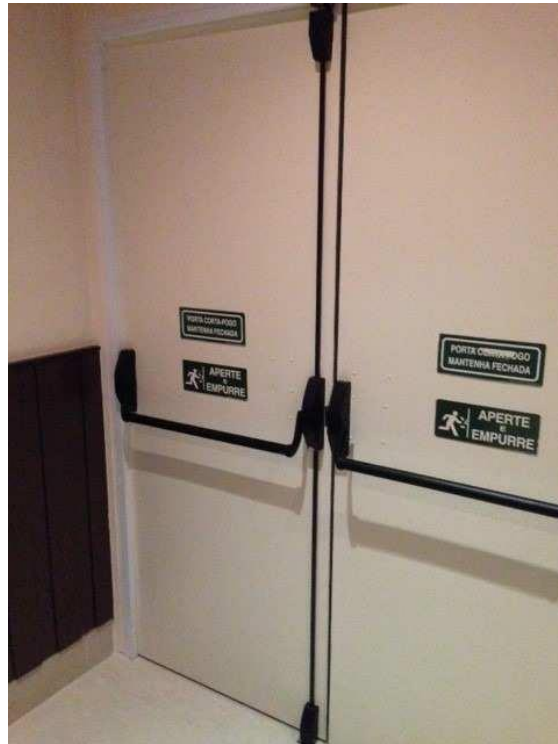
Figura 07: Modelo de barra antipânico com sistema de acionamento via haste vertical metálica.
