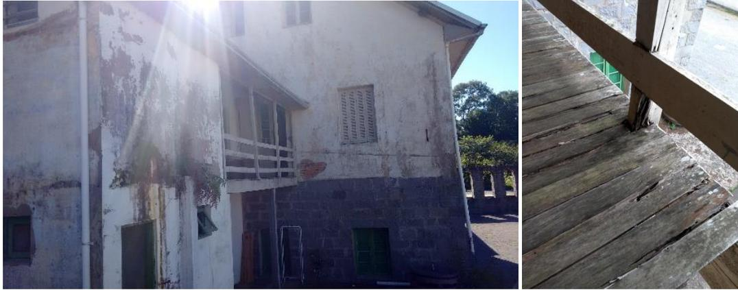
O prédio ao lado, por sua vez, apresenta problemas similares. No pavimento subsolo, há muitos focos de umidade na laje de forro, que se dão, principalmente, pelo terraço frontal que não conta com qualquer impermeabilização ou sistema de recolhimento pluvial, fazendo com que haja empoçamento de água na superfície. Sendo assim, trata-se de mais um amplo espaço existente pouco utilizado.
